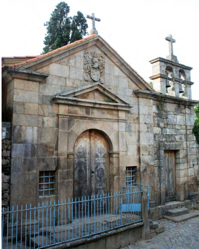
Fig. 4 – Fachada da capela de Nossa Senhora do Desterro, em Granja Nova, onde se insere a pedra de armas da família amado num frontão cuja cimalha é interrompida.
